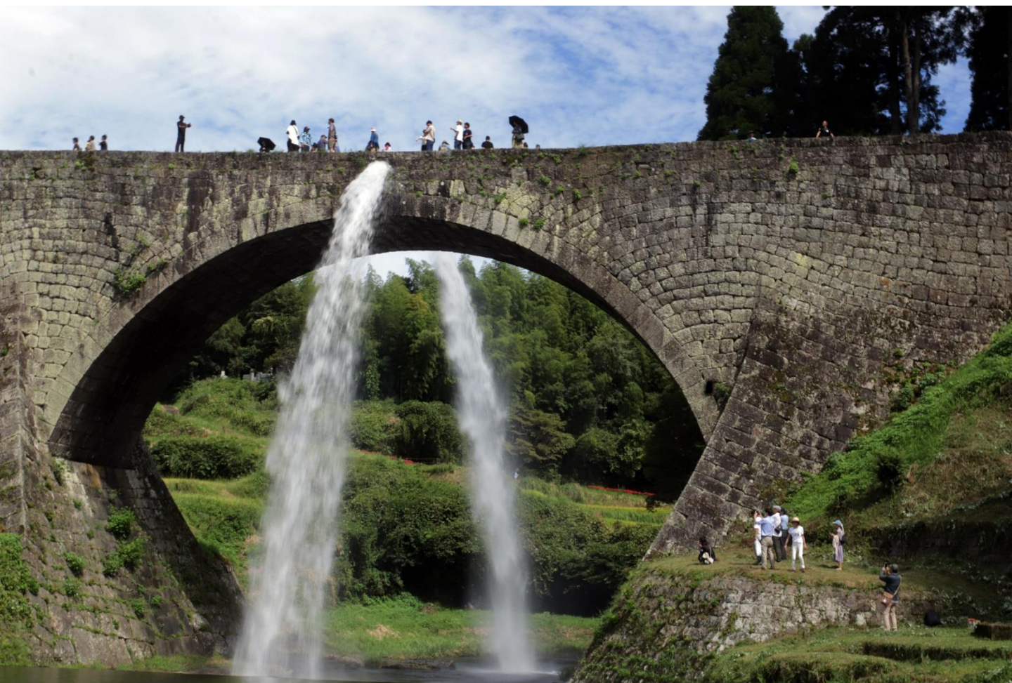
通潤橋(上益城郡山都町) 八代白百合学園高等学校 写真部
